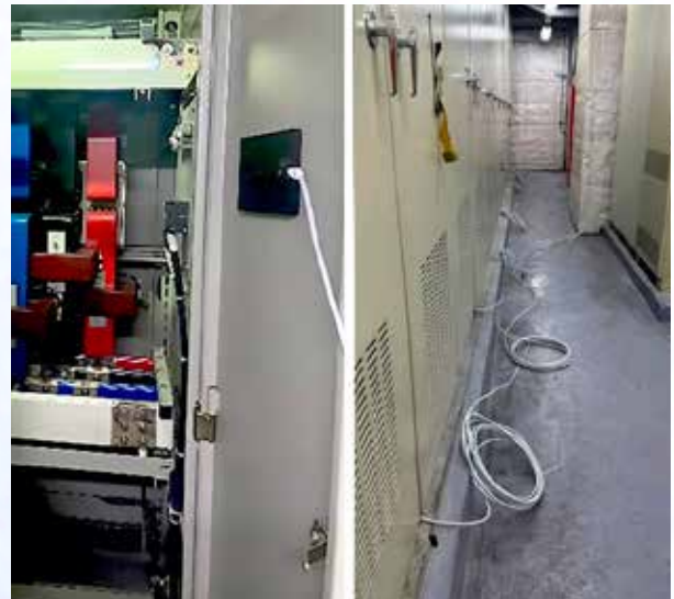
圖（上）：打破過去監測設備主機放在監測專家端的做法，改將小型邊緣主機就放在企業場域內做即時監控，即使細微的異常波動都能自動發出預警，讓現場人員可迅速在第一時間進行異常處理。
