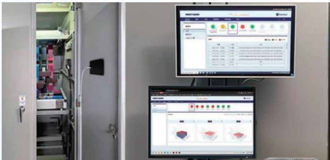
圖（上）：系統界面設計上以直覺式紅綠燈預警顯示，簡單易懂，目標就是讓使用這套設備的企業內部人員即使沒有專業背景，也可以輕鬆掌握設備當下運作狀況。
